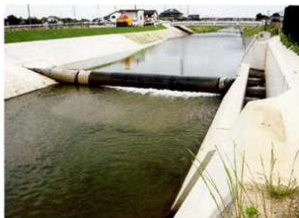
(新)占部川定国堰(平成23年11月)
