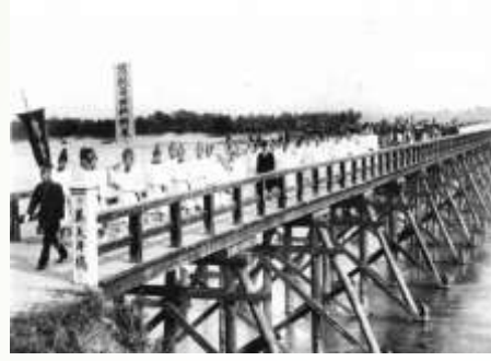
供納米（美矢井橋）
