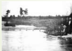
矢作川取り入れ口
